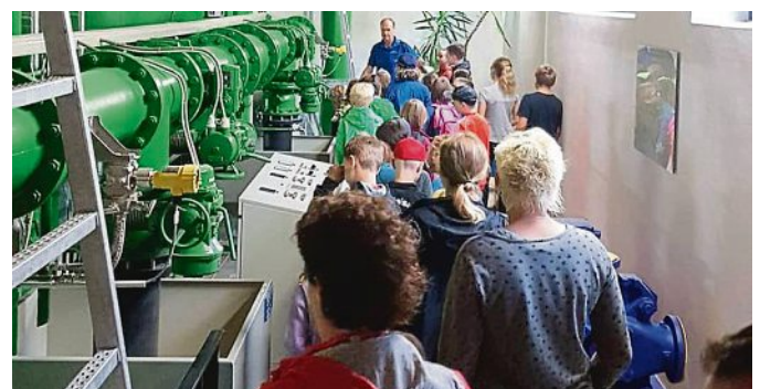
CSU: Gestaltet wurde eine Wissenstour unter dem Motto „Mach dich schlau wie Fritzchen Fuchs: Wir wollen es wissen: Dem Wasser auf der Spur“, konnte ein ganzer Bus voll Wissenswertes über den Weg des Wassers erfahren. Unter der Leitung von Claudia Huber, Hans Seidl, Martina Brunner und Gabi Loder wurde unter anderem das Wasserwerk in Malching, der Hochspeicher in Oberlappach und das Klärwerk in Geiselbullach besichtigt.
