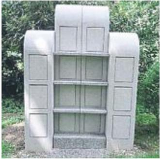
Jahr eine neue Grabstele für 14 Urnenkammern aus Betonfertigteilen aufgestellt. Es sind vier aneinander gestellte Stelen, die äußeren besitzen je drei Kammern, die beiden mittleren Stelen haben vier Kammern und ein vorgelagertes Ablagebrett aus Naturstein. Die äußeren Metallbehälter für Kerzen und Blumen werden Anfang Juli montiert. Die Herstellungskosten belaufen sich auf insgesamt 12 000 Euro. **GEMEINDE/FOTO: TB**
