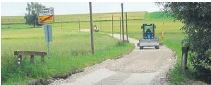
Geplant war nur die Ausbesserung von gebrochenen Betonfahrbahnplatten! Der sehr schlechte Unterbau und der gesamte Zustand des Straßenteilstücks haben dazu geführt,
