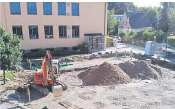
Die Arbeiten für den Neubau des Kinderhortes in der Buschingstraße haben Ende Juni begonnen. Der Aushub für die Fundamente und die Kanalarbeiten sind bereits abgeschlossen. Während der Schulferien soll ein Großteil der Rohbauarbeiten fertiggestellt werden. In dieser Zeit werden ca. 270 Kubikmeter Beton, 30 Tonnen Baustahl und 200 Kubikmeter Ziegelmauerwerk verbaut. Der zweigruppige Kinderhort soll im August 2017 bezugsfertig sein. **GEMEINDE/FOTO: TB**
