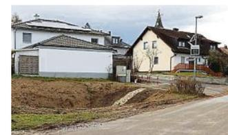
Zwischenzeitlich ist der Endausbau des Hochstattwegs in Überacker größtenteils abgeschlossen. Die Fahrbahndecke und die Zufahrten sind fertiggestellt, der Straßenrand wurde mit Rasenfugenpflaster befestigt. Im Rahmen der Herstellung der Entwässerung ist ein Sickerbecken an der Fußberger Straße angelegt worden, das noch bepflanzt wird.
