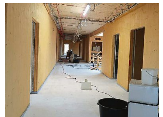
Im Haus wurden eine Wärmepumpe und eine Fußbodenheizung eingebaut.
