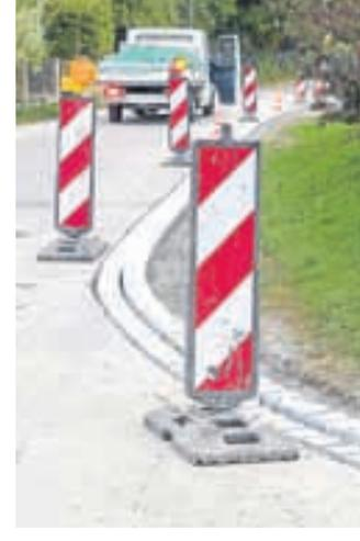
führung der Arbeiten erfolgte am 28. September. Es wird im ersten Schritt erst die Ostseite mit dem Zweizeiler aus Granit versehen und dann erfolgt die Westseite. Auch wird im Bereich der Stefansberger Straße Haus Nr. 10 und 10a eine Rinne eingebaut werden. Es ist angedacht, die Arbeiten etwa bis zum Monatsende Oktober zum Abschluss zu bringen. GEMEINDE/FOTO: TB
