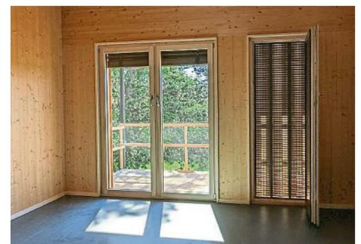
Passive Lüftungselemente (re.) sorgen für Zufuhr insektenfreier Frischluft. Eine Nachtlüftung an heißen Sommertagen ist möglich.
