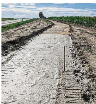
Radweg-Bau: Kreisstraße FFB 8 Richtung Malching
