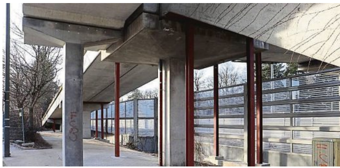
Eine Sicherheitsmaßnahme aus dem Jahr 2019 war der Einbau von Stahlstützen
