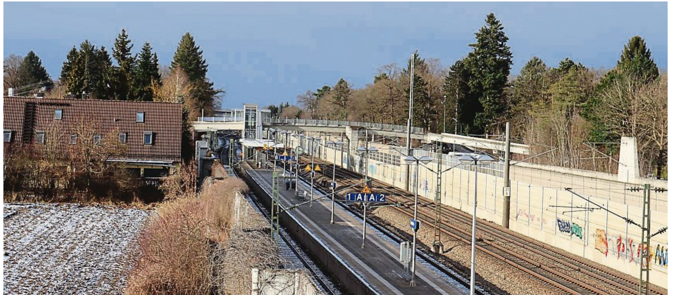
Sicht auf den Bahnhof Gernlinden mit Brücke von Osten (Merianbrücke).
