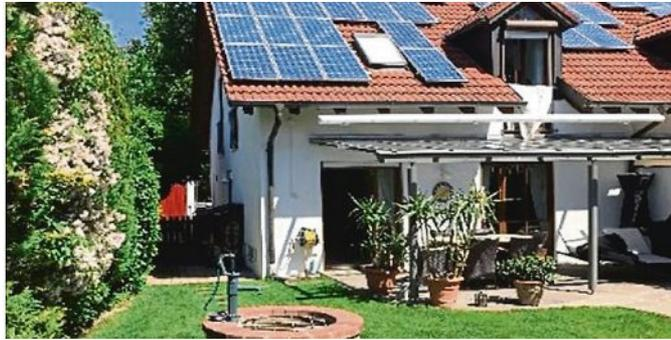
ode erfolgt die Stromerzeugung vor allem durch die Brennstoffzelle mit einer Leistung von bis zu maximal 18 kW pro Tag, in den „Sonnen“-Monaten die PV-Anlage mit einer Spitzenleistung von 4,32 kW. Zur Pufferung und Bereitstellung des erzeugten Stroms dient ein 5-kWh-Bat-
